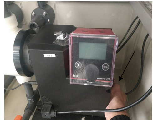
Figura 2 - cabos sinais externos, desrosquear o conector
